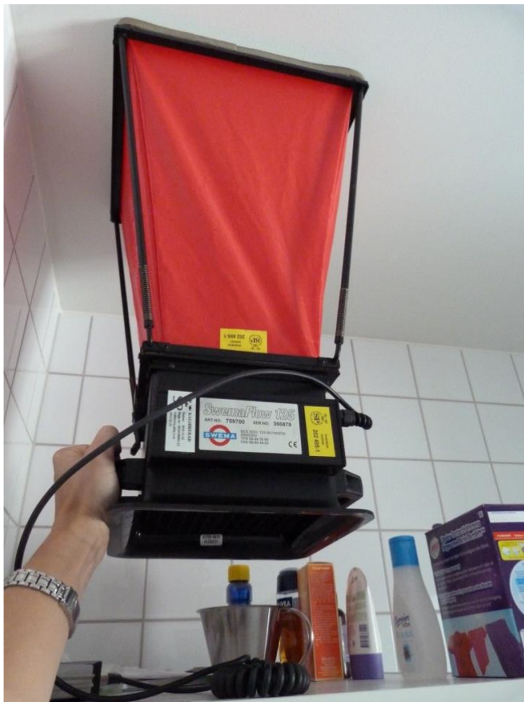
Figur 6.1 Bild av mätning med mätstos på ett frånluftsdon i ett grovkök (Sikander m.fl. 2011).
